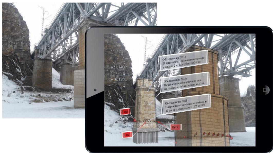
Рис. 7. Пример возможного использования результатов цифрового проектирования и технологии дополненной реальности при последующем обследовании (технология для применения на практике аттестованными специалистами)
