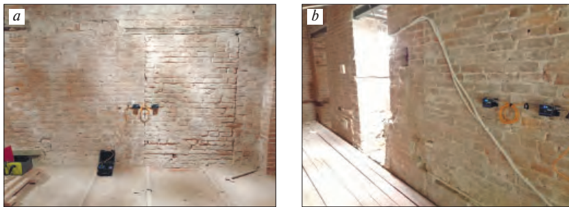
Рис. 5. Фотофиксация исследуемых заложённых проемов: a – проем № 1 (датчики измеряют колебания зоны шва); b – проем № 2 (датчики измеряют кладку заложённого проема)
