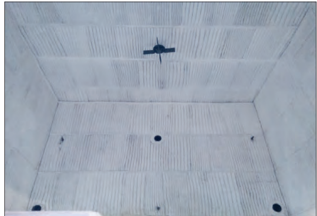
Рис. 4. Футеровка печи Fig. 4. Kiln lining
